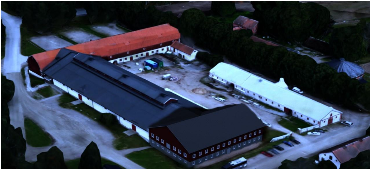
En bild som visar vår anläggning med det nya stallet längst fram i mitten.
